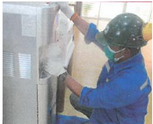
ครั้งที่ 4 วันที่ 9 สิงหาคม 2566 (จุดตรวจ ณ อาคารผู้ป่วยใน)
